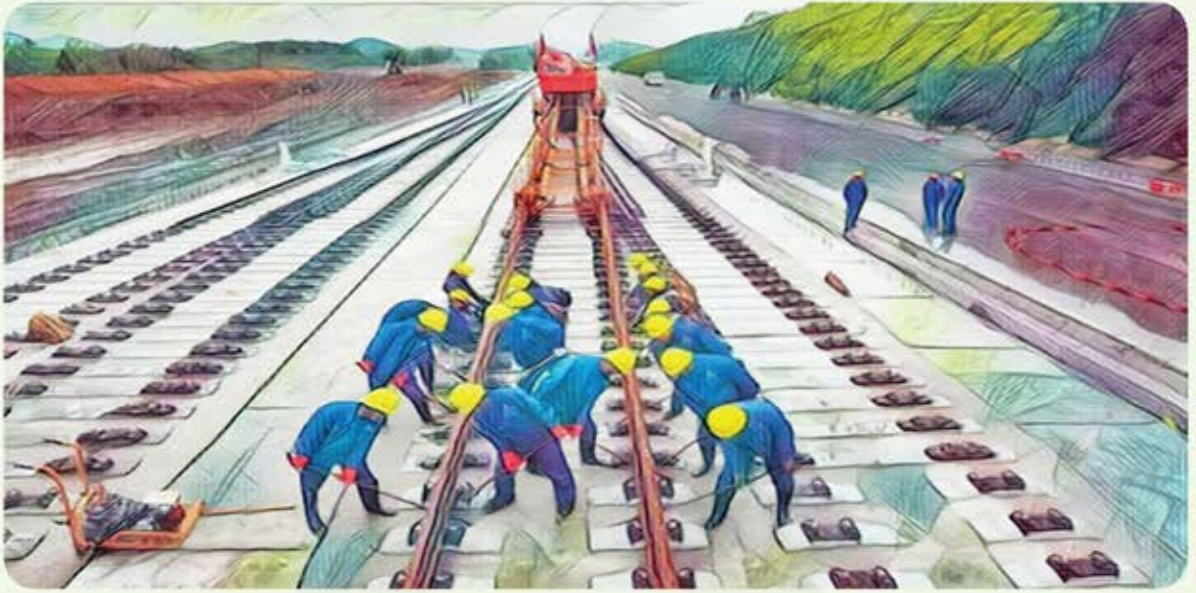
Một số công nhân đang lắp đặt đường ray xe lửa
